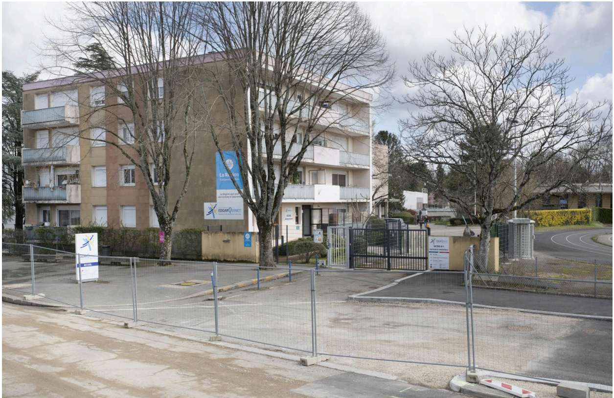
Entrée du lycée, accueil et logements de fonction
