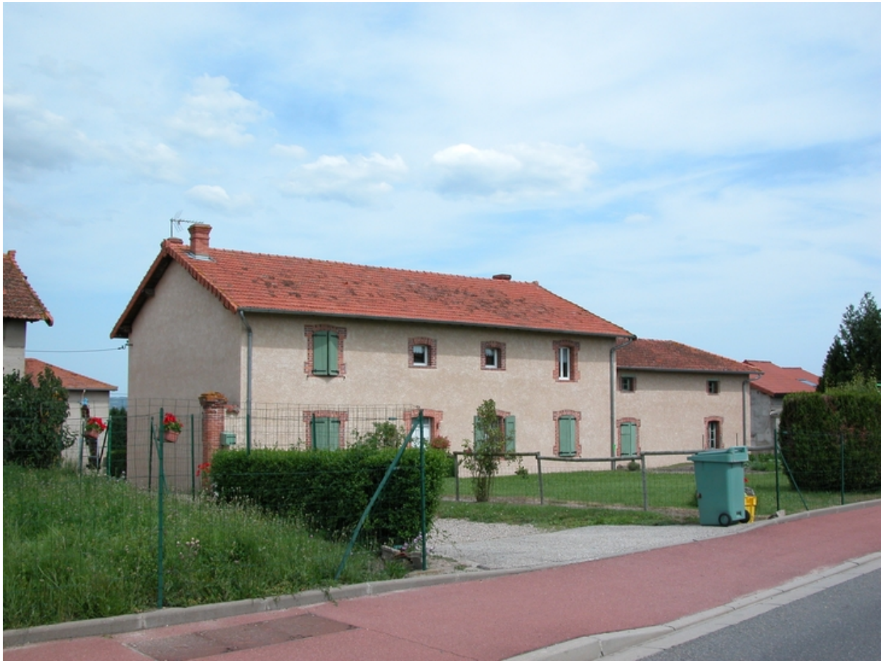
Vue d'ensemble du logis, depuis le nord-ouest.
