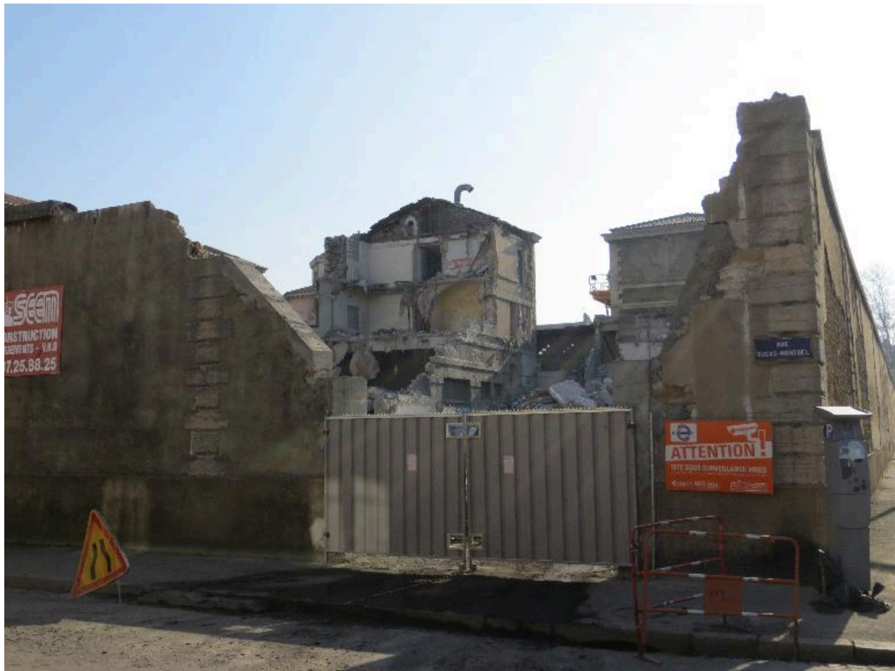
Etat au 19 février 2013 : bâtiment de détention nord-ouest en cours de démolition depuis l'angle des rues Dugas-Montbel / Delandine
