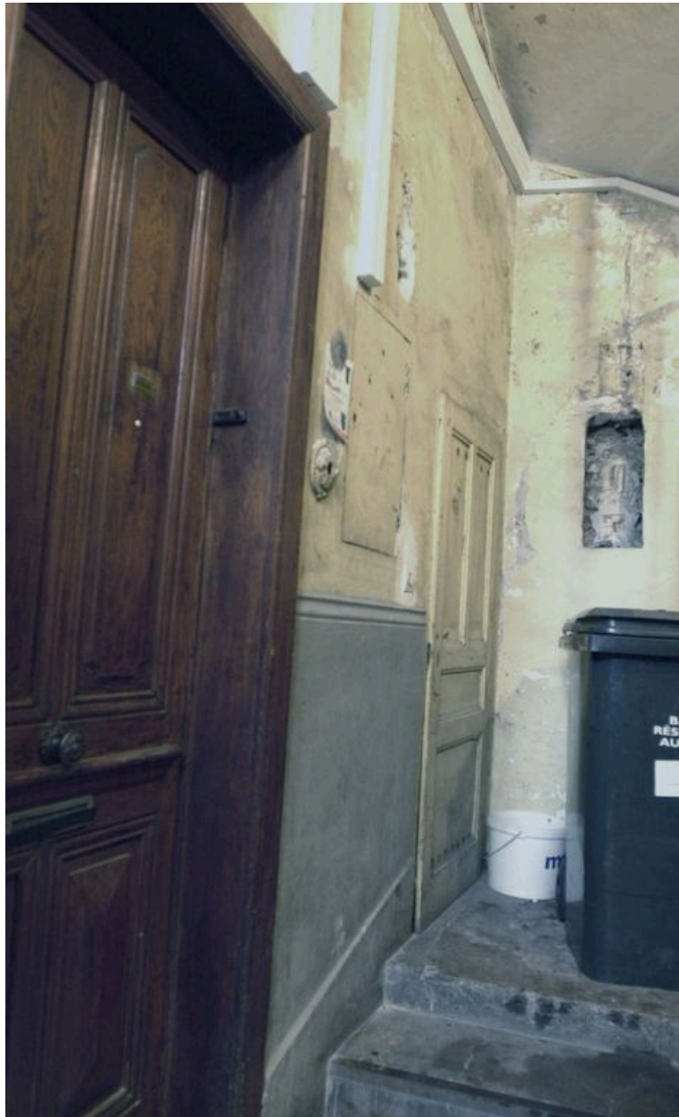
Porte de service et petite niche dans l'angle nord-ouest du vestibule
