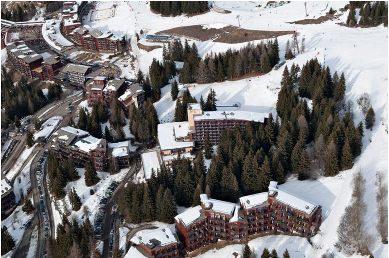
Vue aérienne rapprochée depuis le sud. Charmettoger
