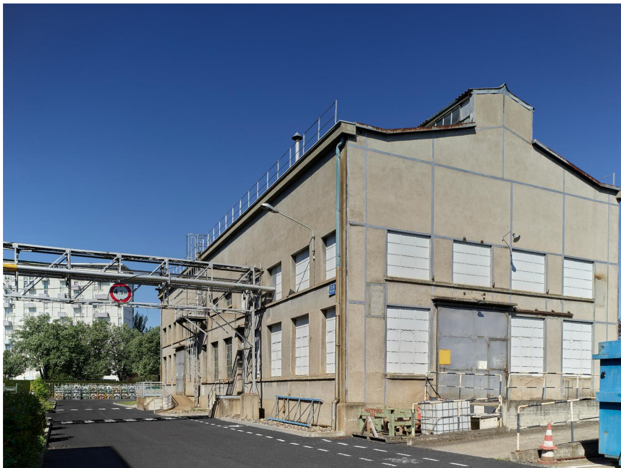
Le bâtiment B103, rue de Jumeaux.
