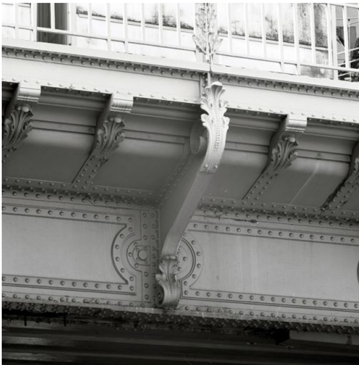
Travée de rive, quai Rambaud : détail d'une console
