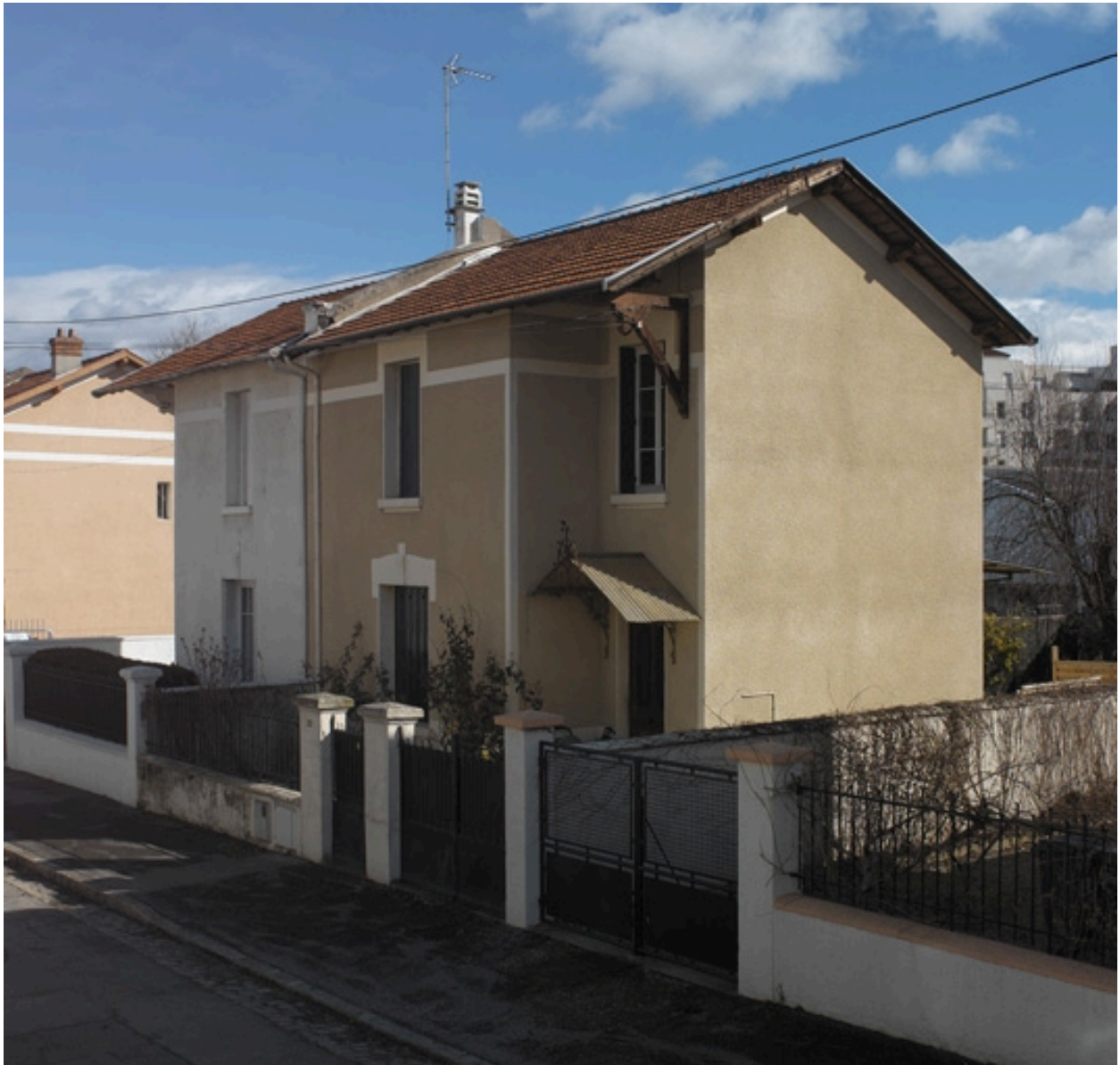
Vue sud-ouest, 23, 21 rue Littré (BP 54, 55), maison double avec décor de menuiserie et entrée façade principale
