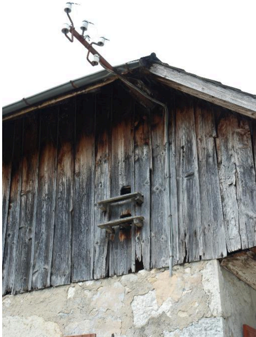
Détail du pignon sud de l'habitation : pigeonnier.
