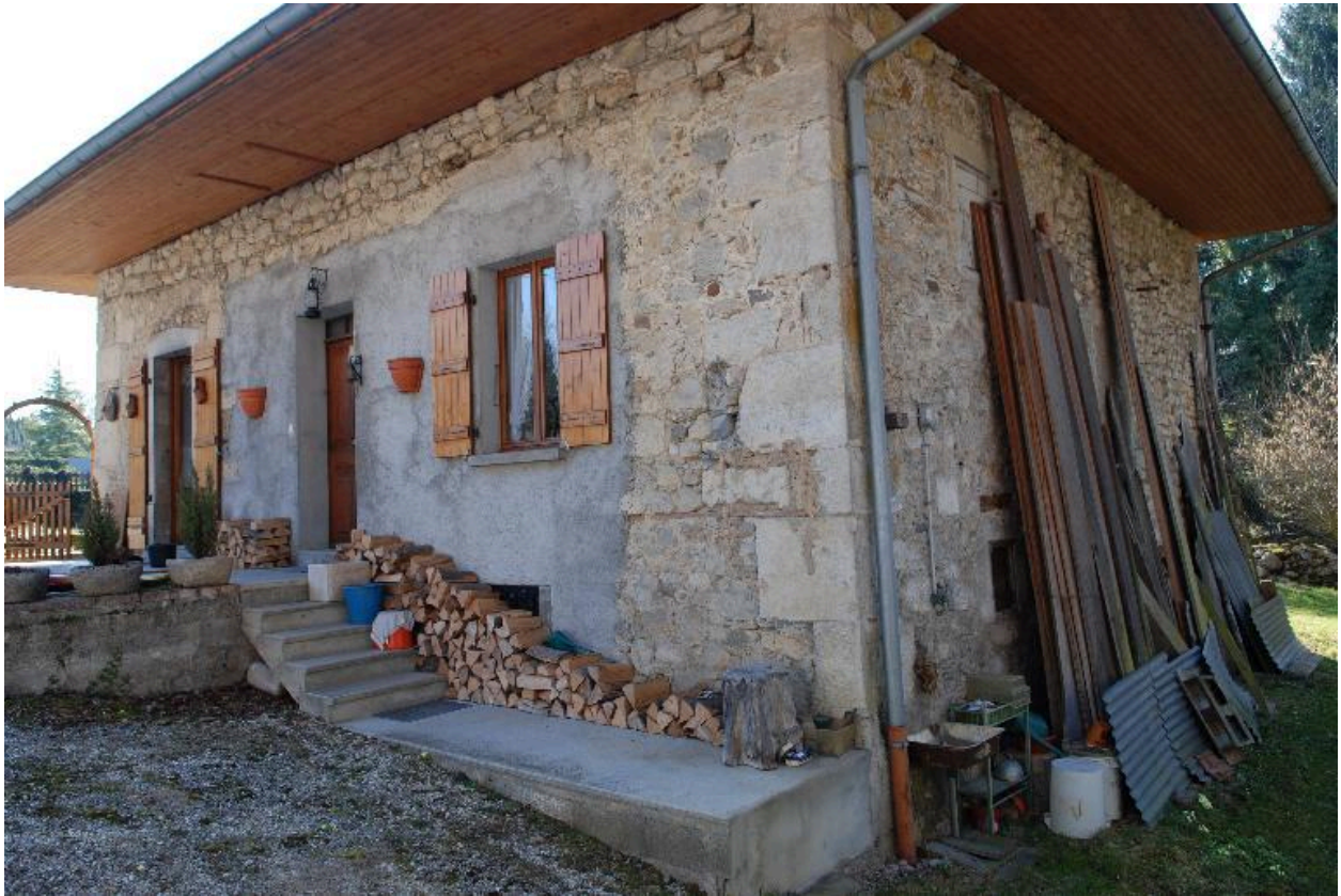
Vue rapprochée de la façade principale du bâtiment d'habitation
