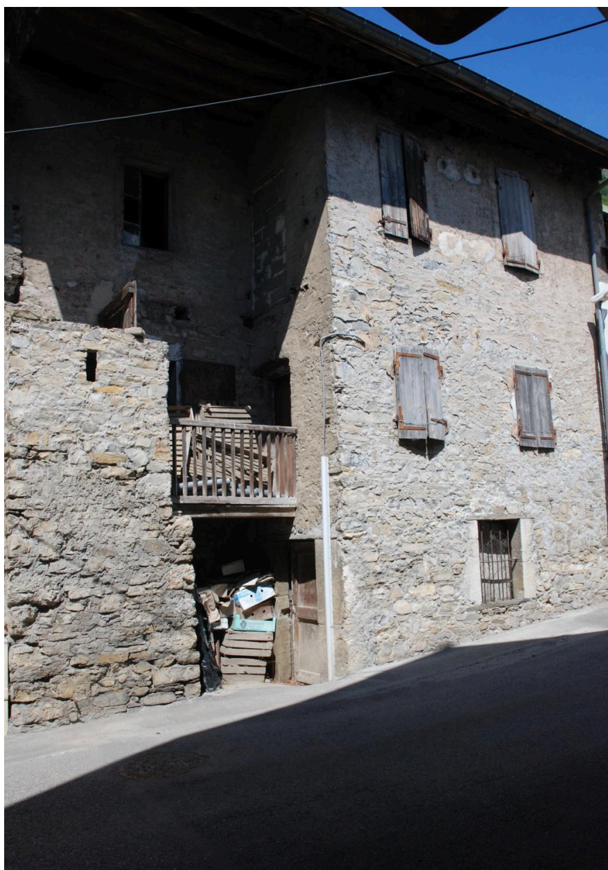
Maison de vigneron (2018 C2 327). Vue arrière, côté est.
