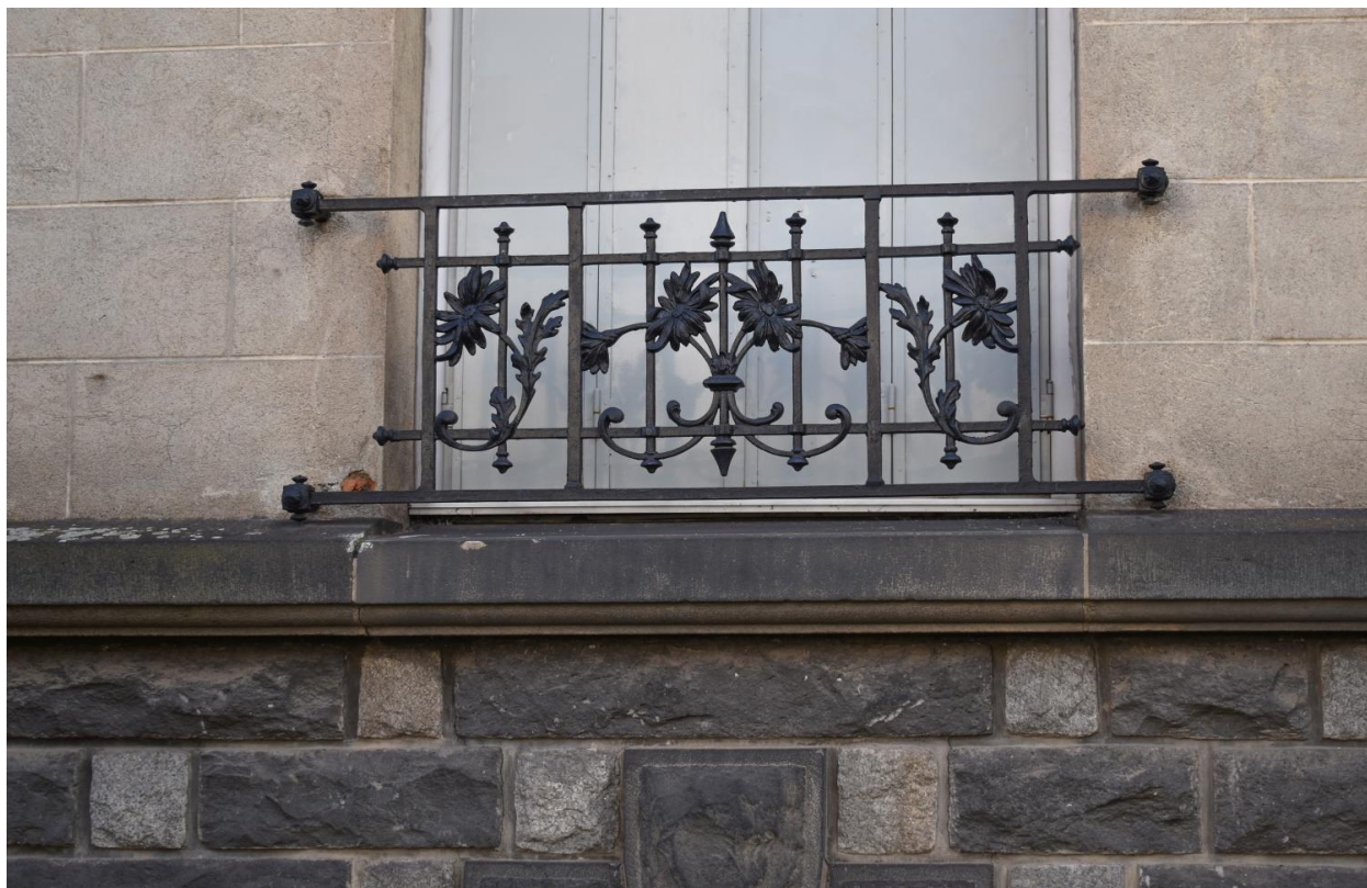
Garde-corps des baies, 11 boulevard Fleury
