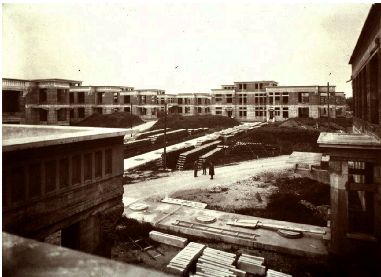
L'hôpital en construction. Vue depuis le pavillon K. Photogr., Jules Sylvestre, vers 1930 (BM Lyon)
