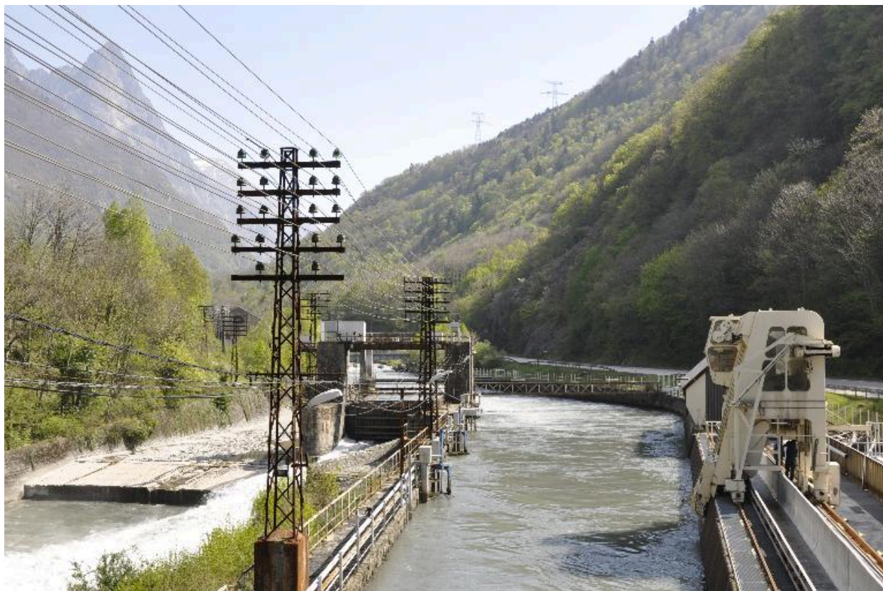
Vue des installations du canal de Rioupéroux
