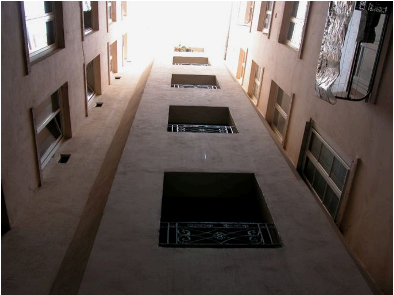
Cour, élévation de la cage d'escalier
