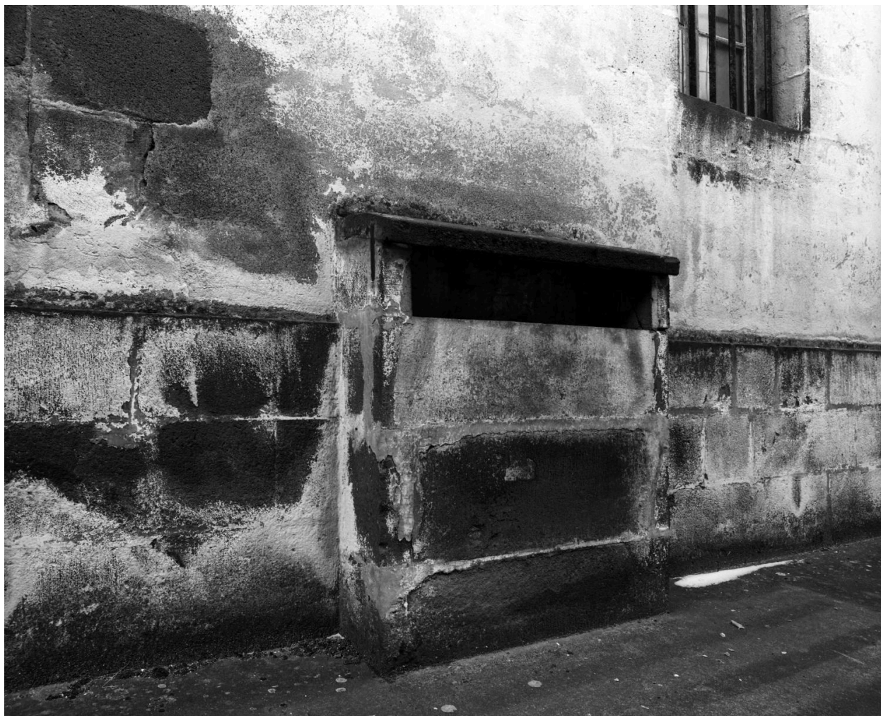
Bâtiment E (démoli). Deuxième sopirail à partir de l'est.
