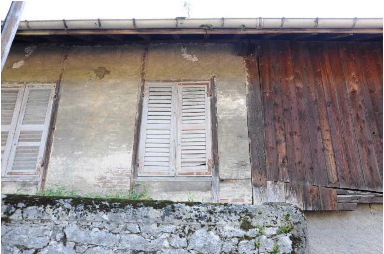
Détail de la partie supérieure de l'élévation sud
