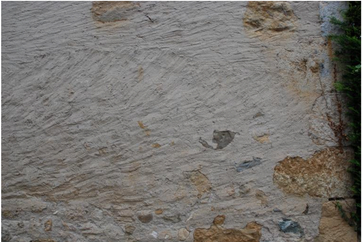
Maison (2017 A1 674), non repérée. Détail de l'enduit en façade arrière.
