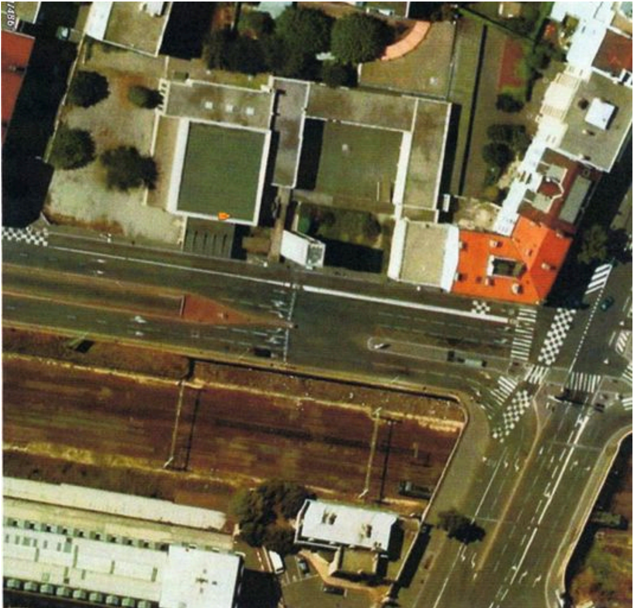
Vue aérienne à la verticale
