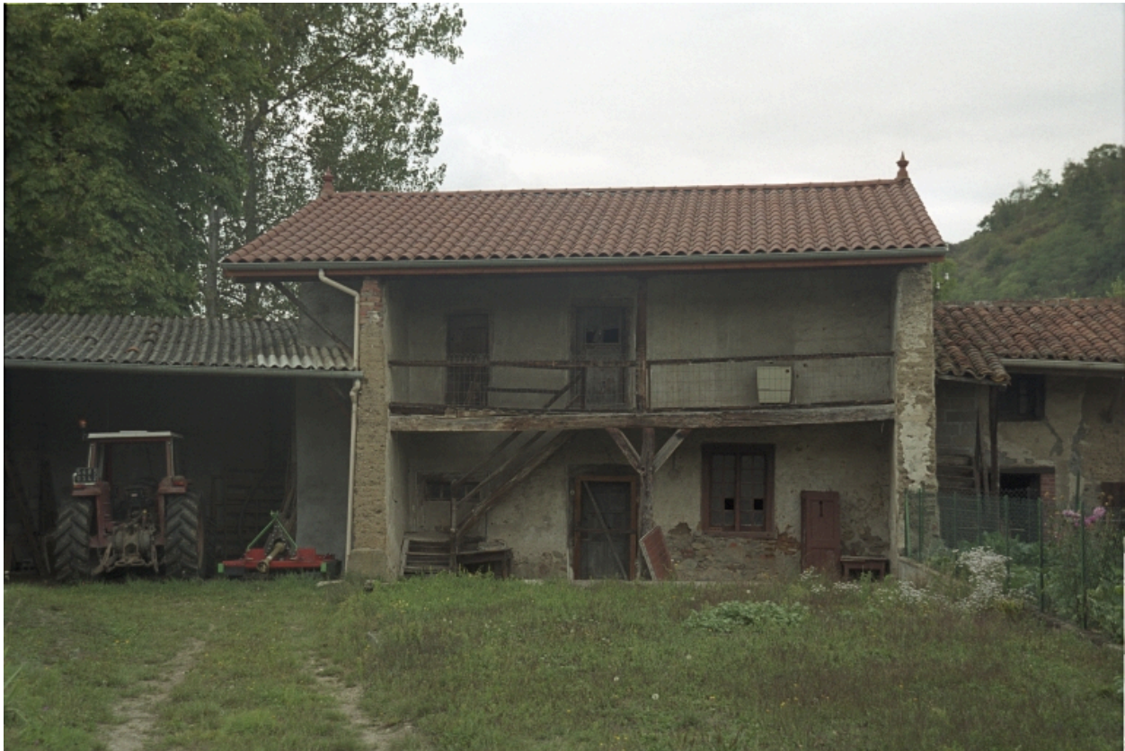
Boën, l'Argentière, (1986 AP 203), type A1. Vue d'ensemble du logis (en 2001).
