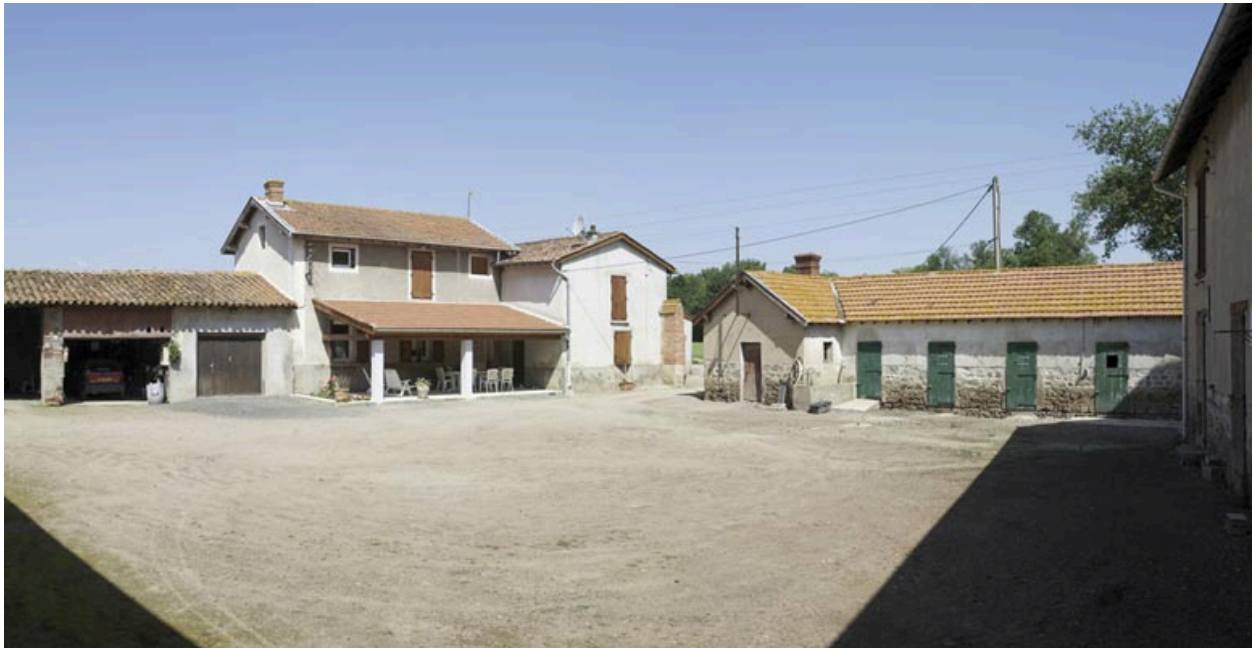
Vue d'ensemble intérieure de la cour, depuis l'est : logis, remise, porcherie.
