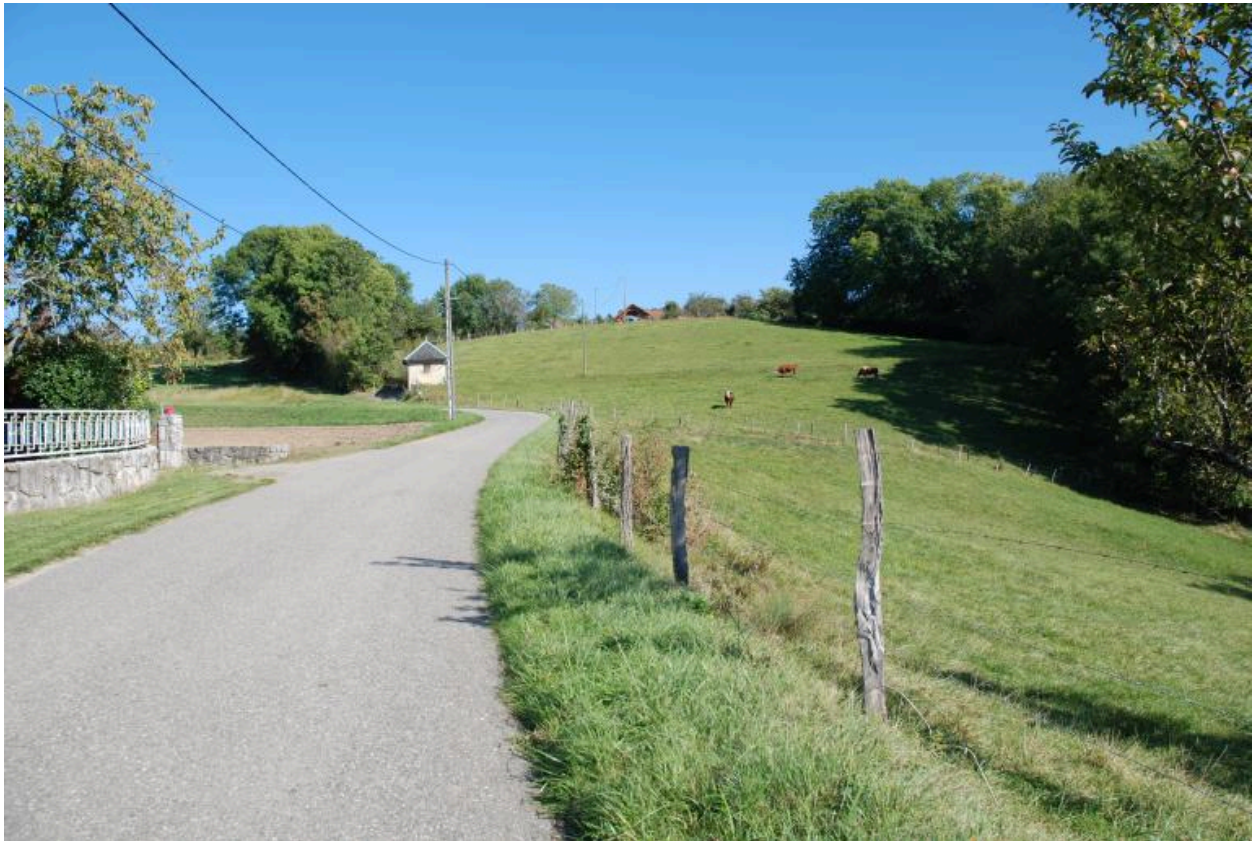
Petit bâtiment en pisé aux Adrets (non cadastré, sur 2016 B9 737).
