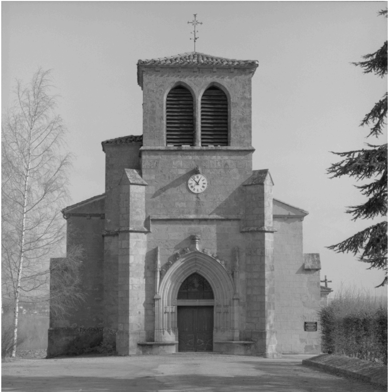
Vue d'ensemble de la façade occidentale de l'église.
