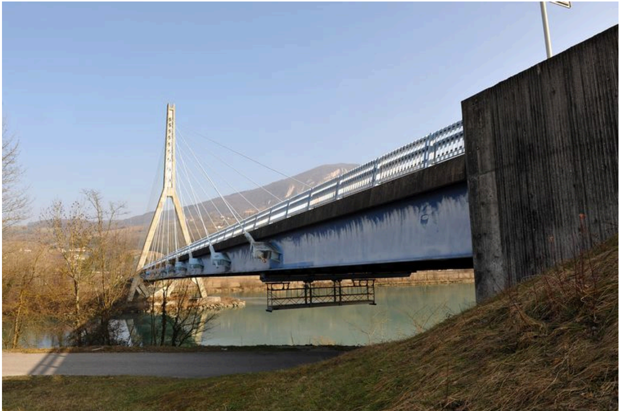
Vue partielle, de côté, culée et travée gauche, face aval (depuis la rive gauche)
