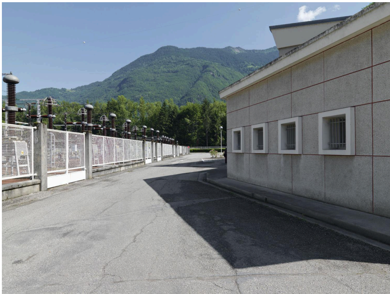
Détail façade de la Centrale
