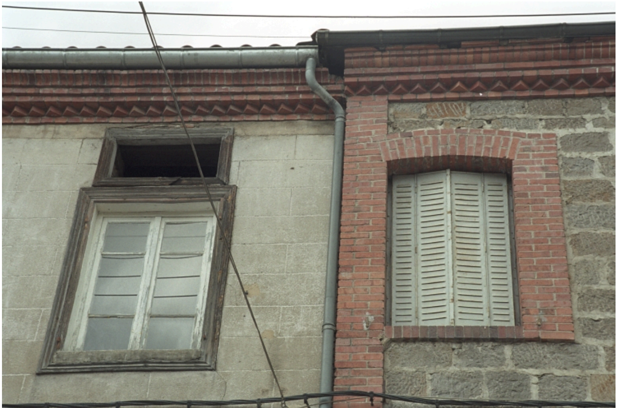
Au Bourg, maison avec commerce (1986 C2 725). Bâtiment en moellons avec chaîne d'angle et corniche en brique. Détail des baies et corniches.
