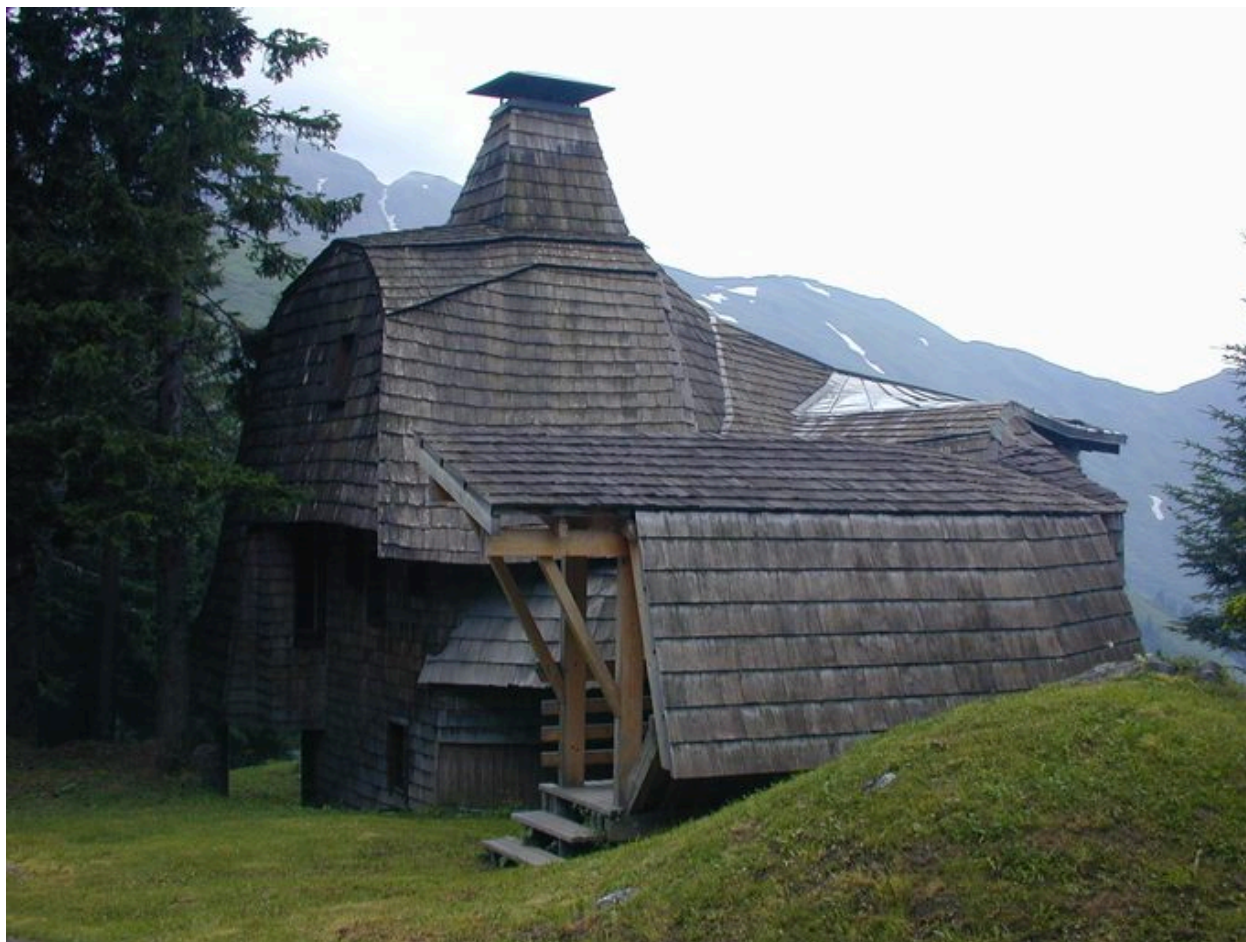
Vue d'ensemble de la façade amont
