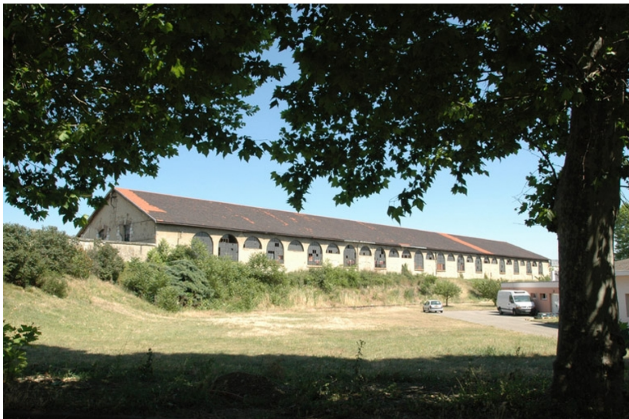
Grande halle qui risque d'être démolie
