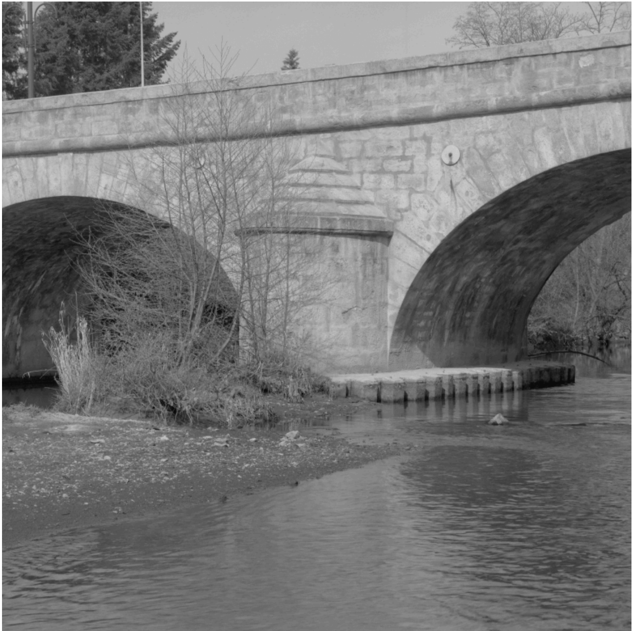
Vue du pont, de l'est : détail.
