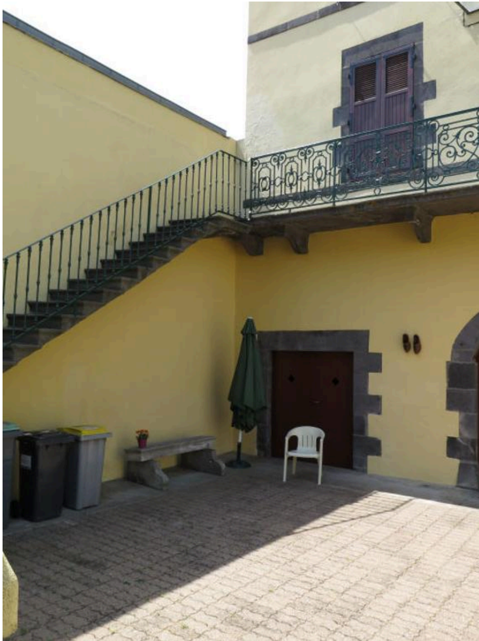
Vue partielle de l'escalier et du balcon
