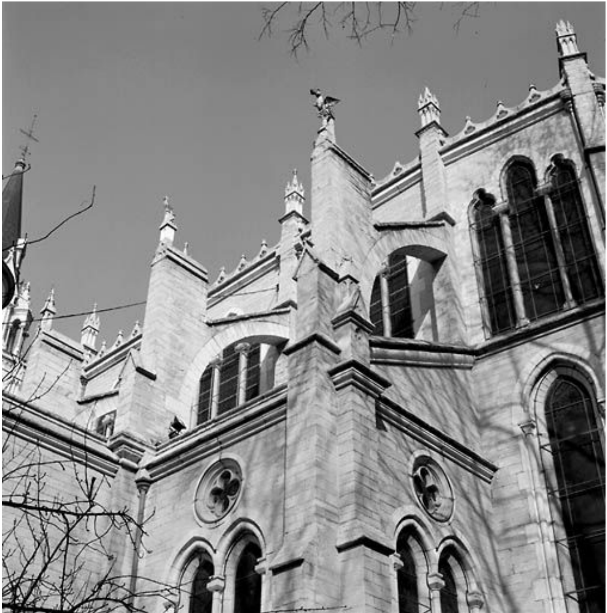
Elévation sud : partie supérieure de la chapelle : quadrilobes, arcs-boutants, pinacles, sculptures d'amortissement
