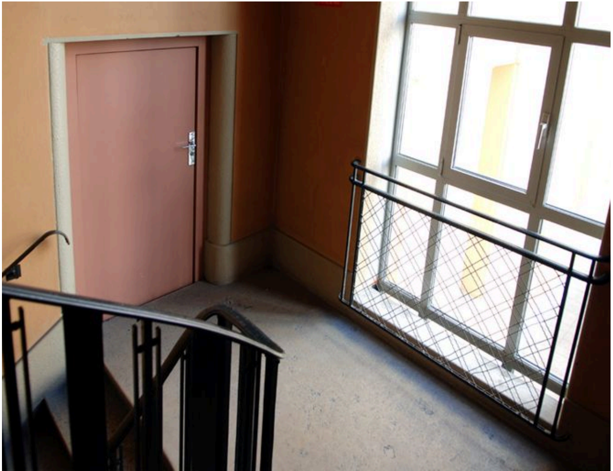
Bâtiment Leperc, escalier, palier du niveau intermédiaire entre le 2e et le 3e étage.
