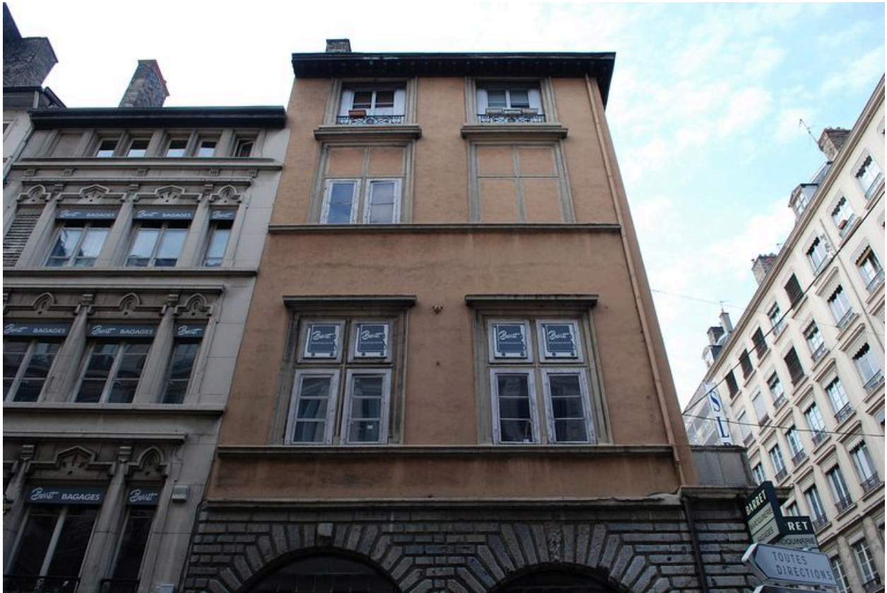
Elévation nord : partie supérieure
