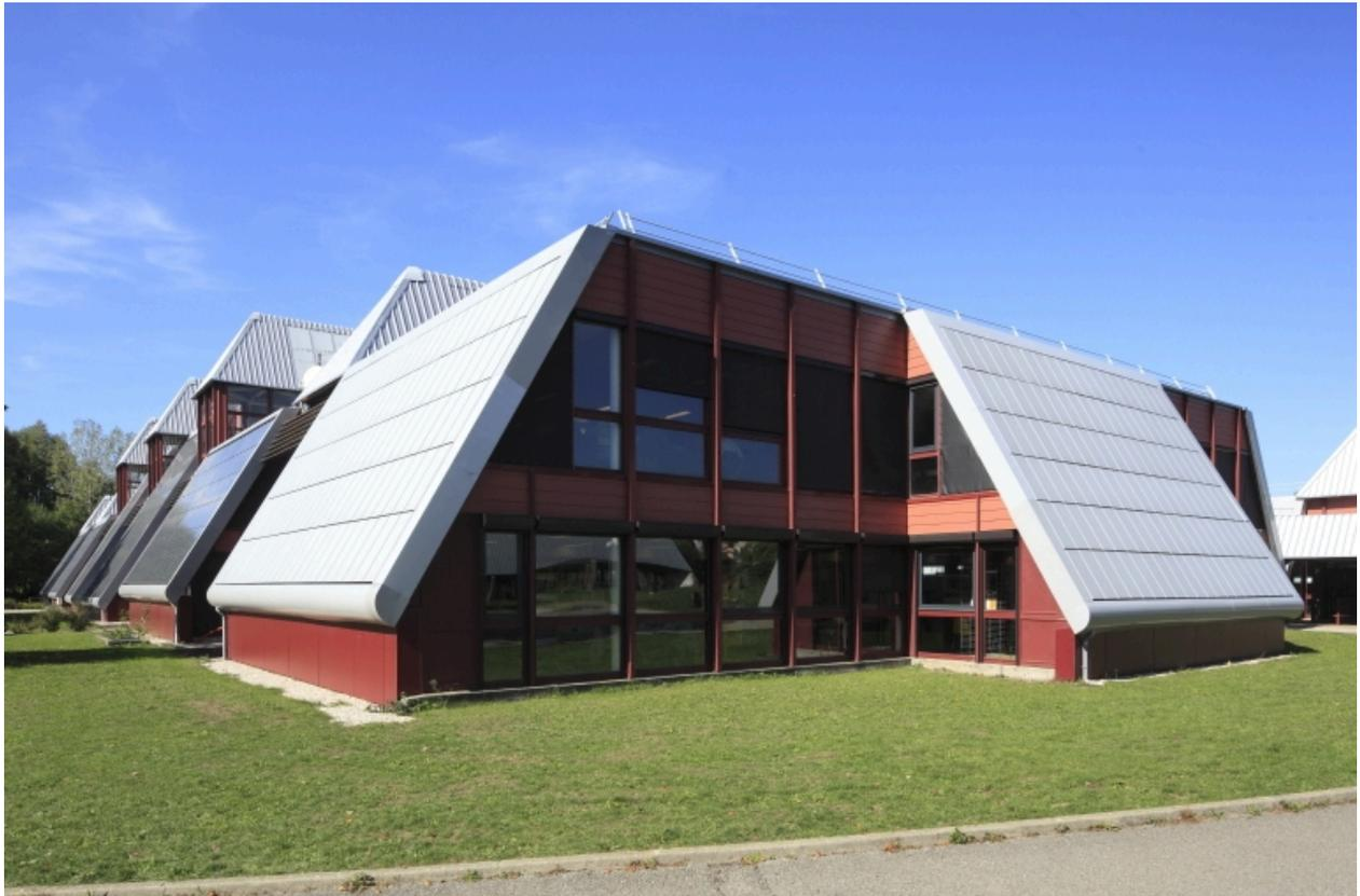
Bâtiment F, façade sud-est, côté CDI. Les panneaux solaires autrefois implantés ont été supprimés et remplacés par des bacs en tôle.
