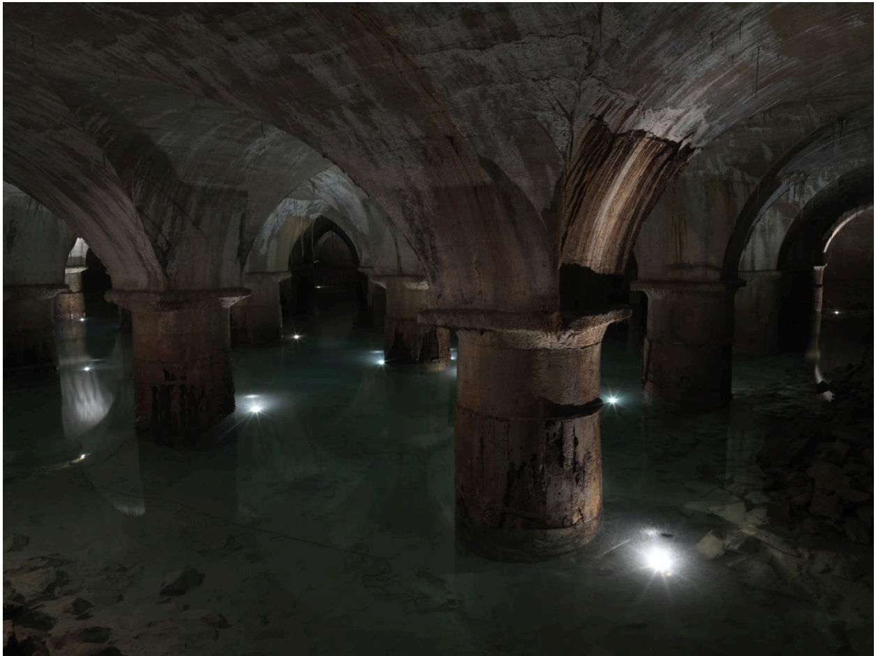
Vue d'ensemble des bassins filtrants
