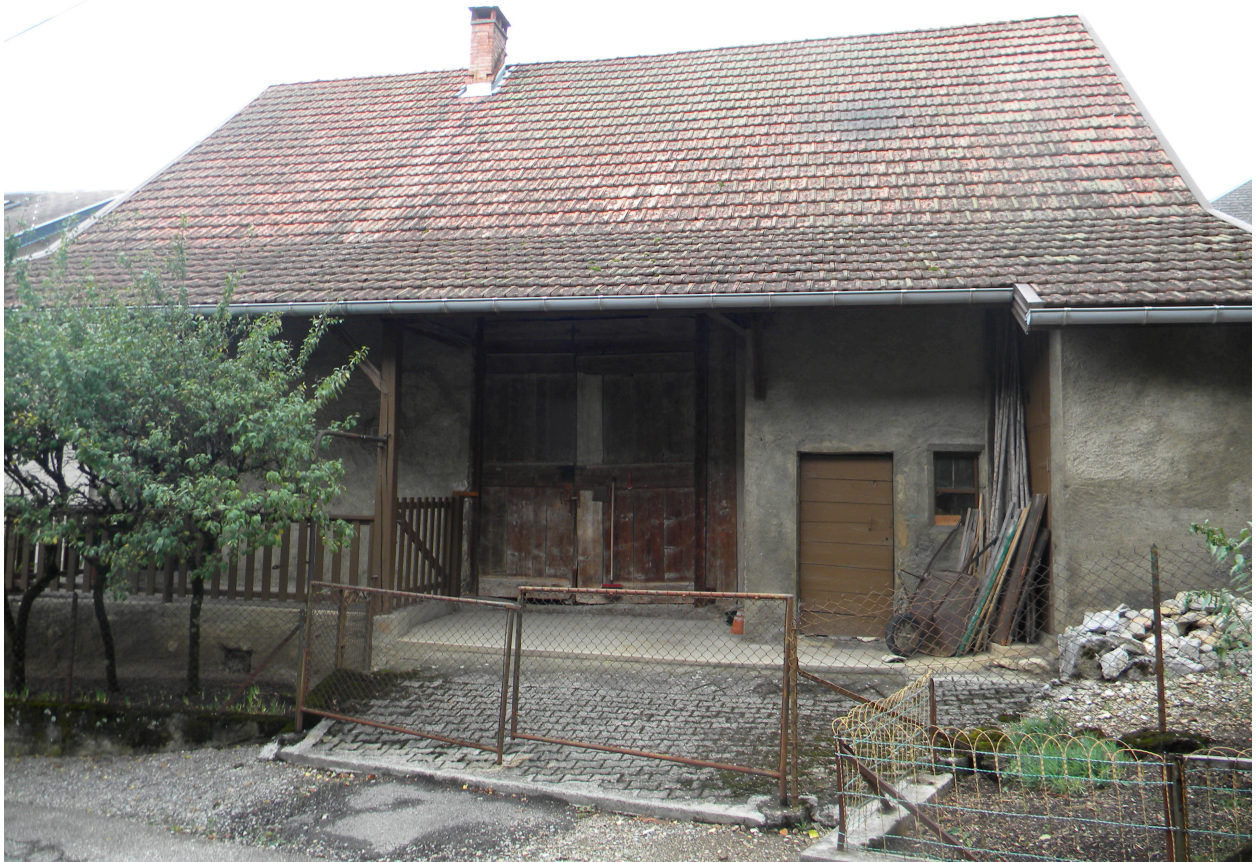
Vue de la façade principale avec la juxtaposition des fonctions
