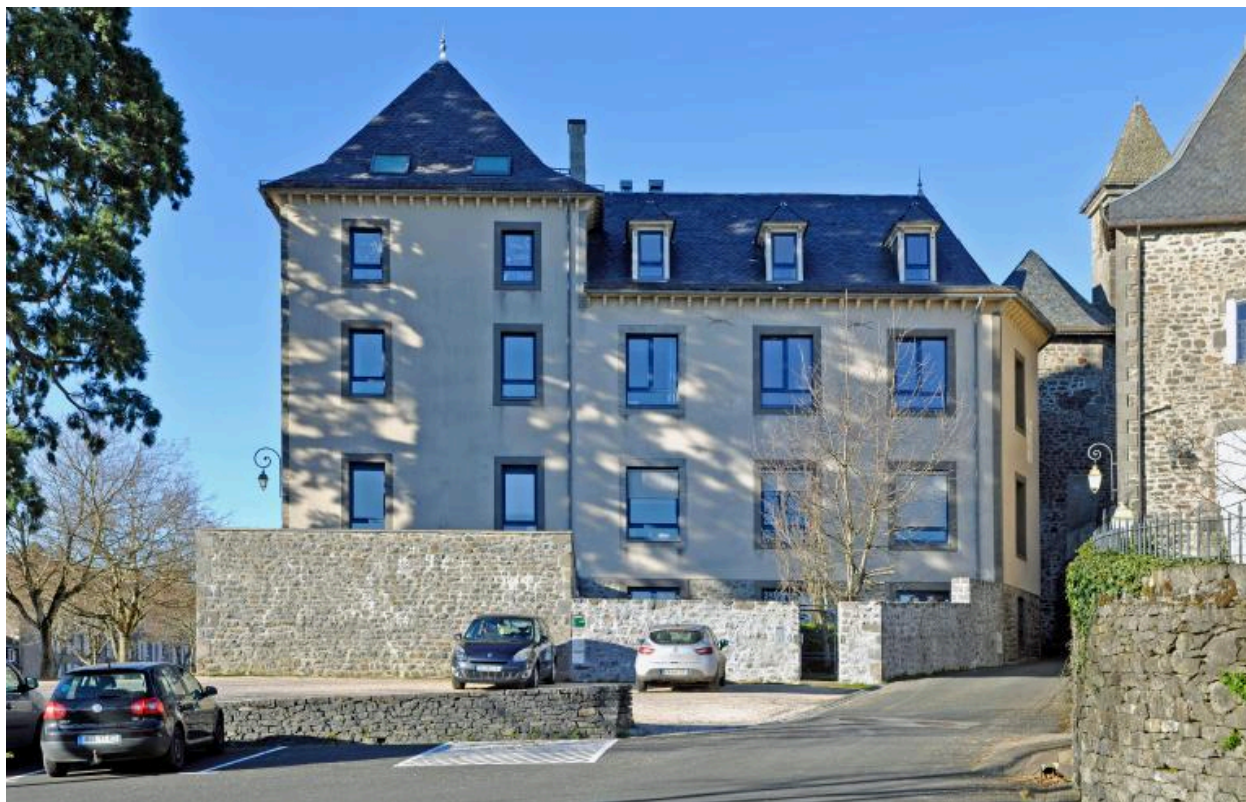
Elévation latérale sud
