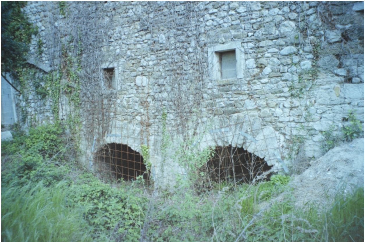
Élévation ouest, détail des arches ménagées sous le moulin, pour le canal d'amenée et de sortie de l'eau.
