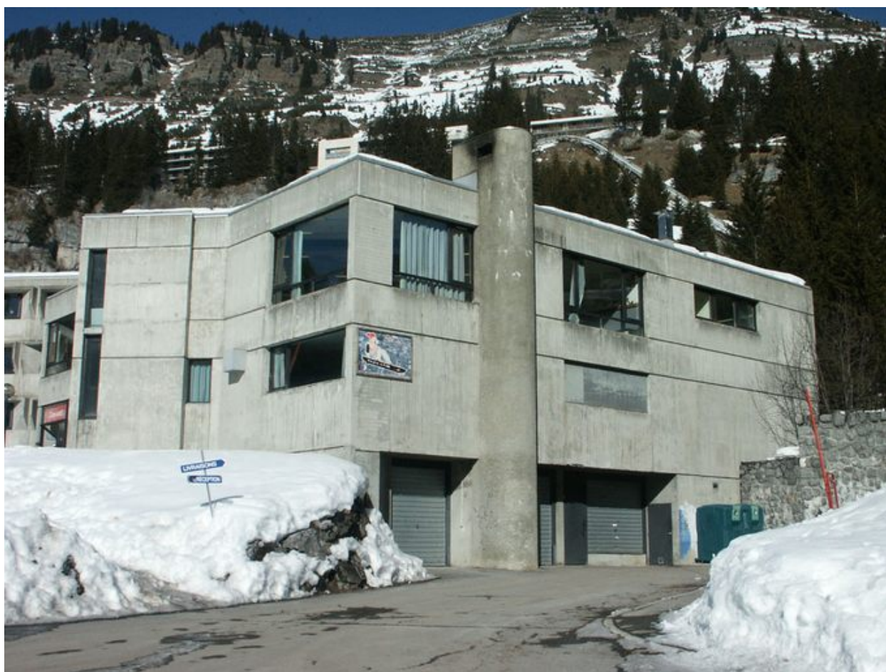
Le bâtiment d'entrée avant réfection. Vue depuis le sud-est
