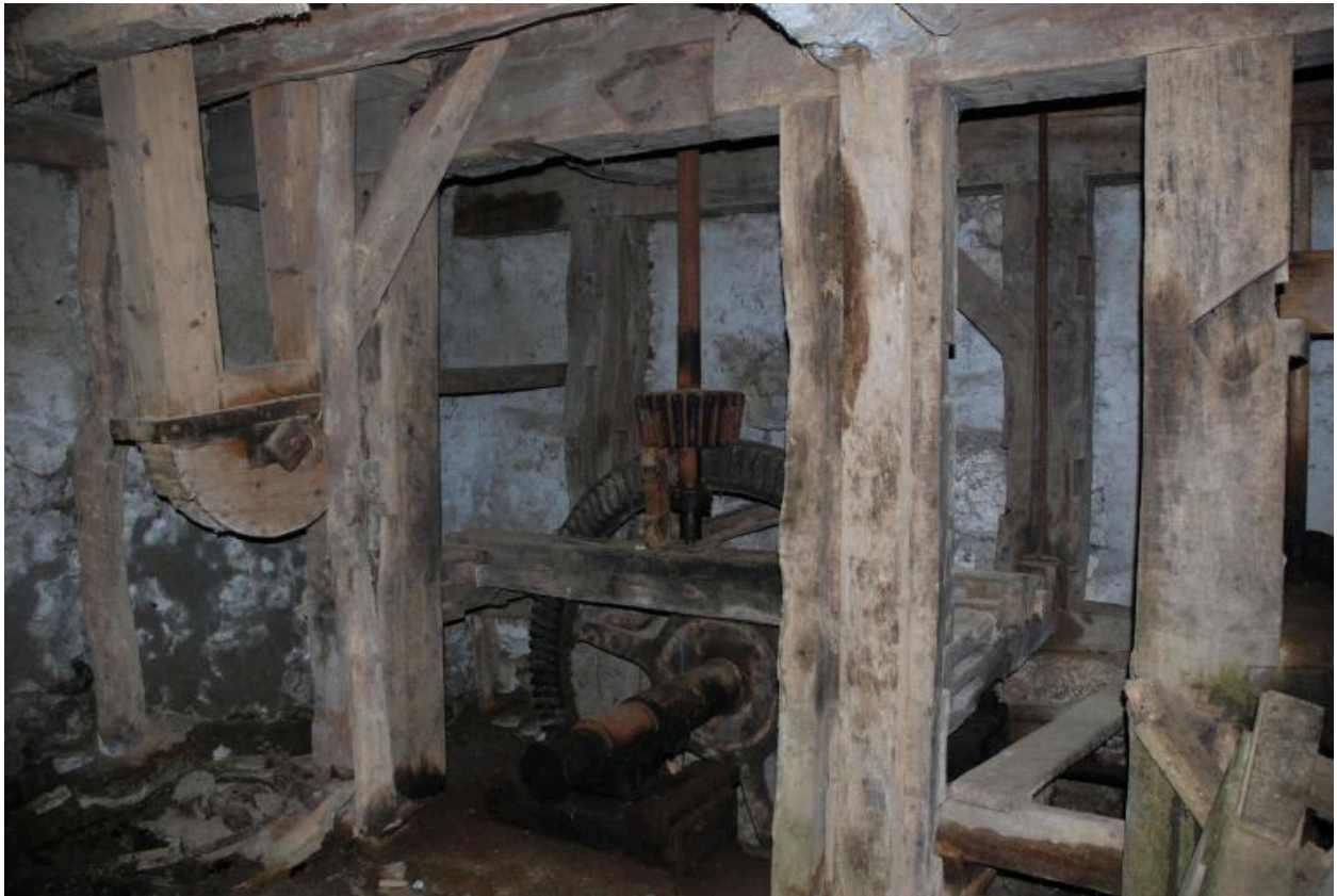
Vue intérieure de l'étage de soubassement, partie nord-est : axe de la roue à aubes.
