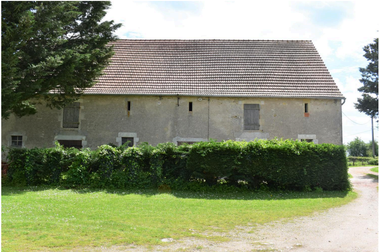
Vue générale de la grange sud.
