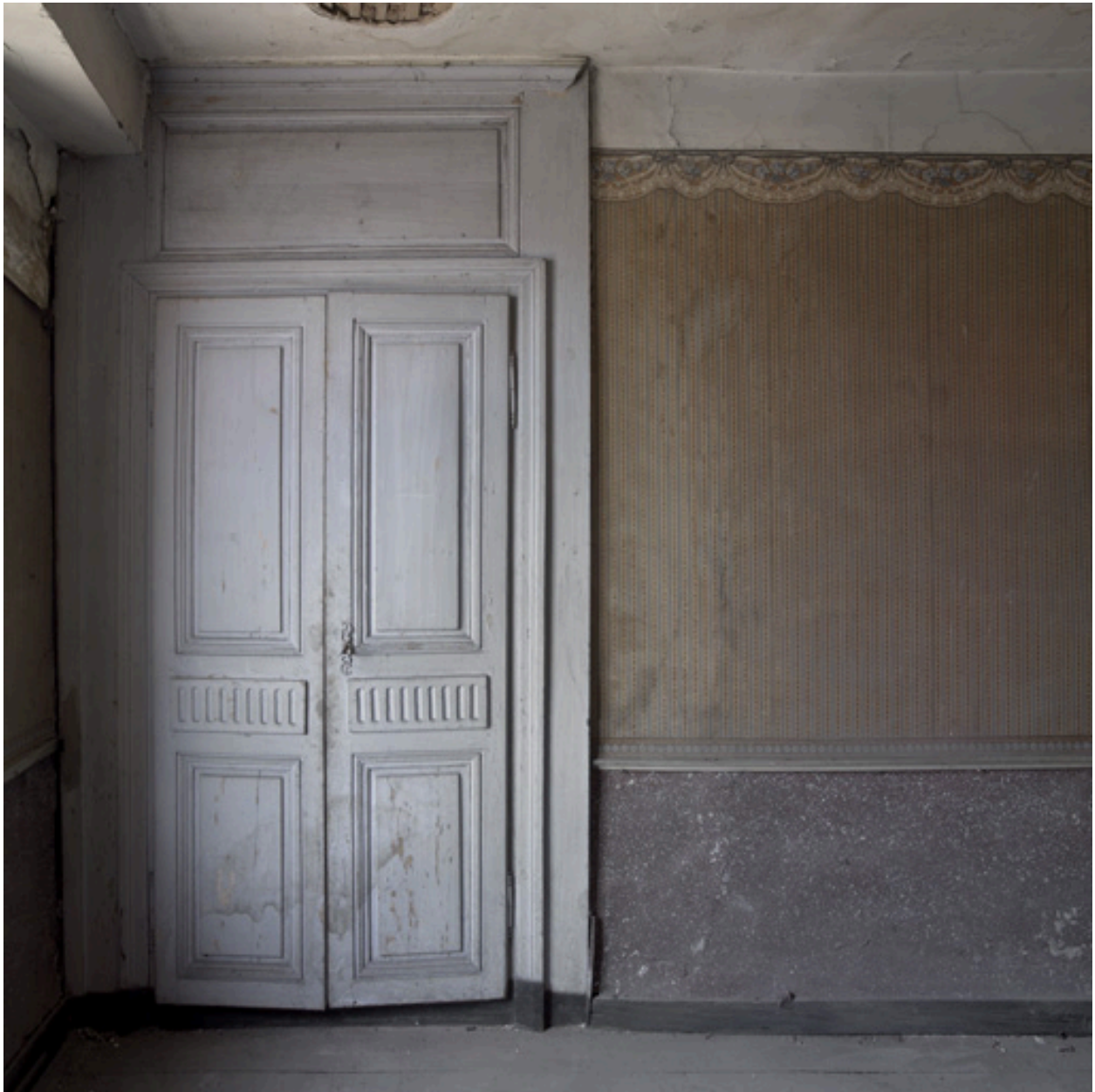
Vue partielle d'une chambre au 2e étage.
