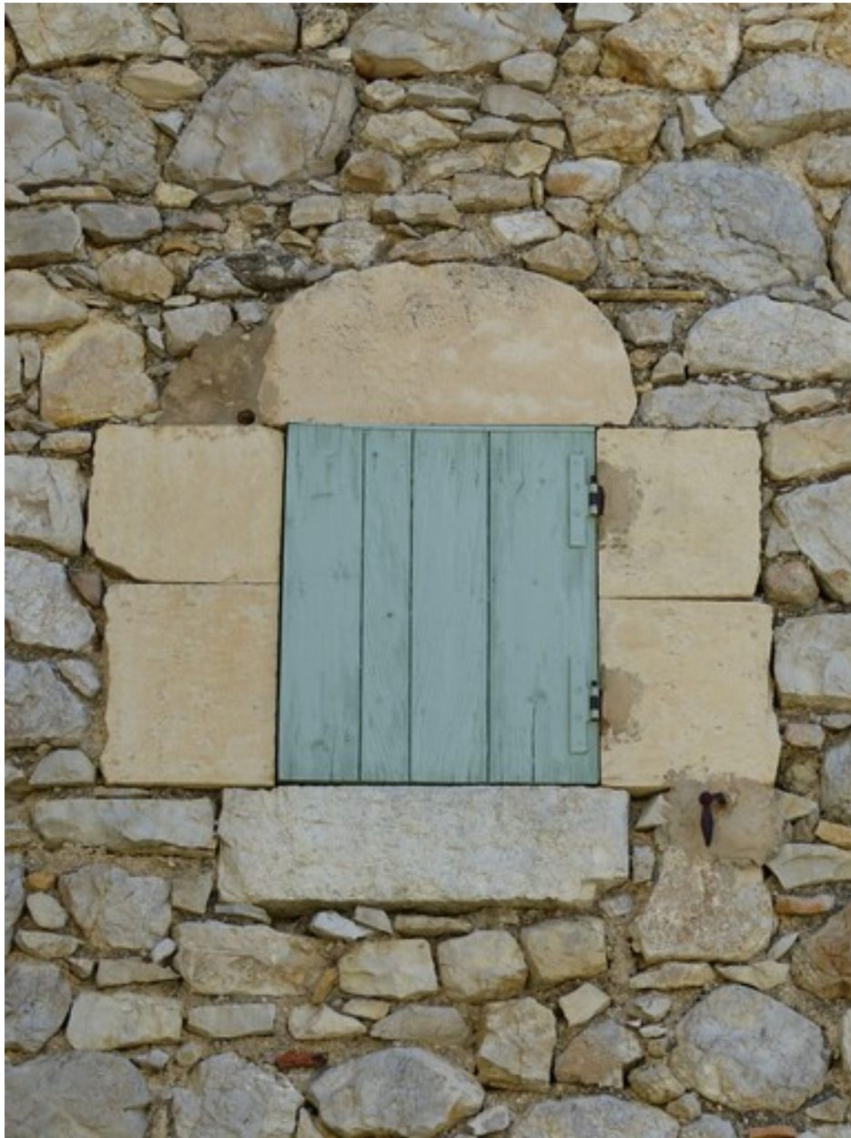
Partie sud-est. Elévation ouest, partie nord. Deuxième niveau, fenêtre.
