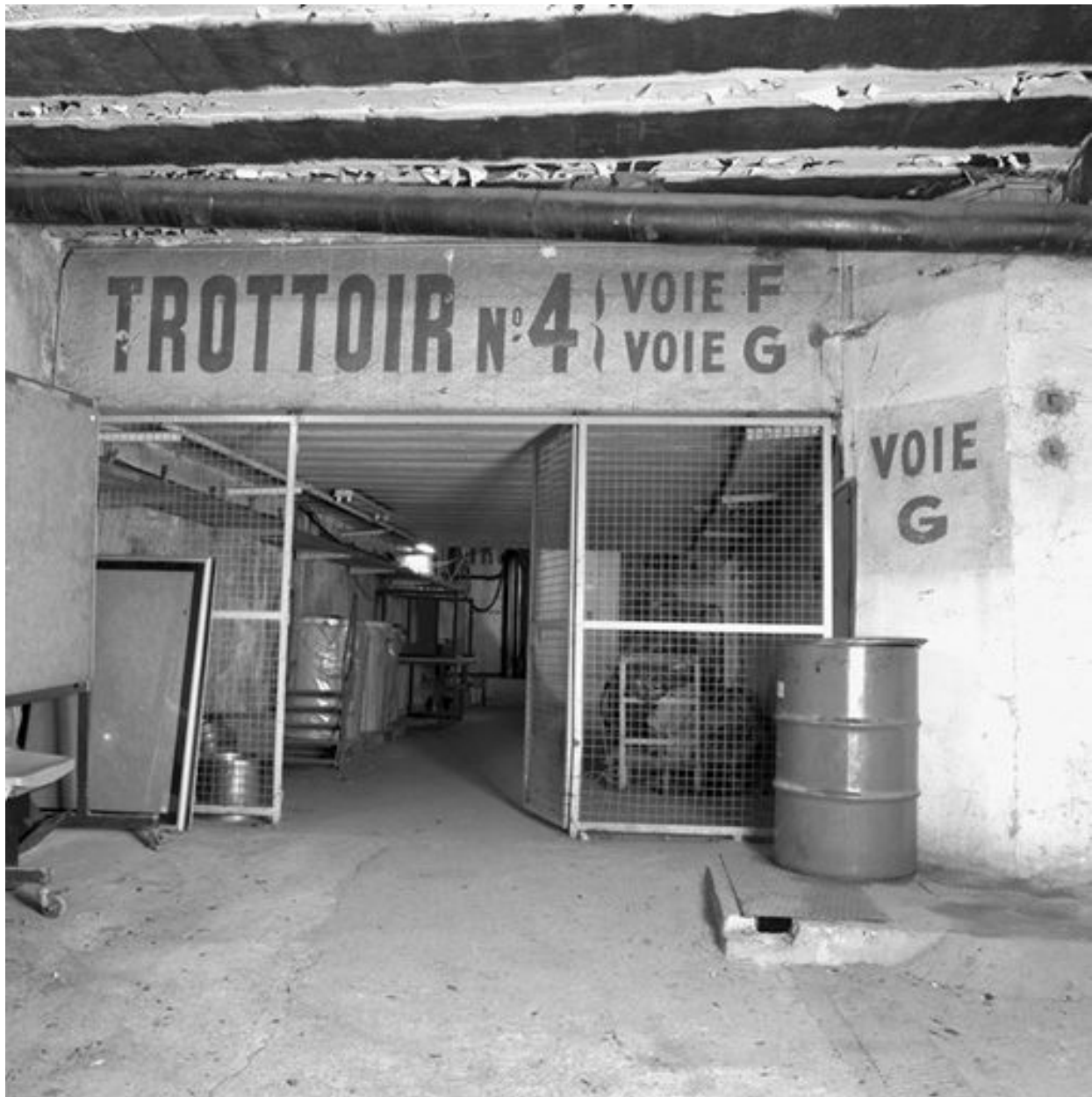
Le bâtiment-voyageurs : souterrain côté Rhône accessible depuis la porte 30 du quai n°1, accès au trottoir n°4
