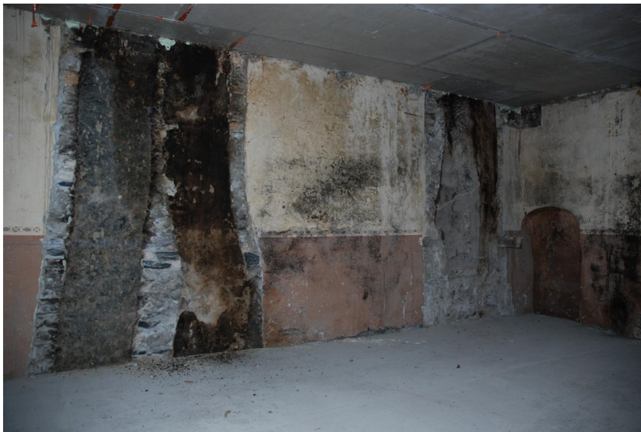
Vue intérieure du 2e étage : pièce nord, niche et vestiges de cheminées.
