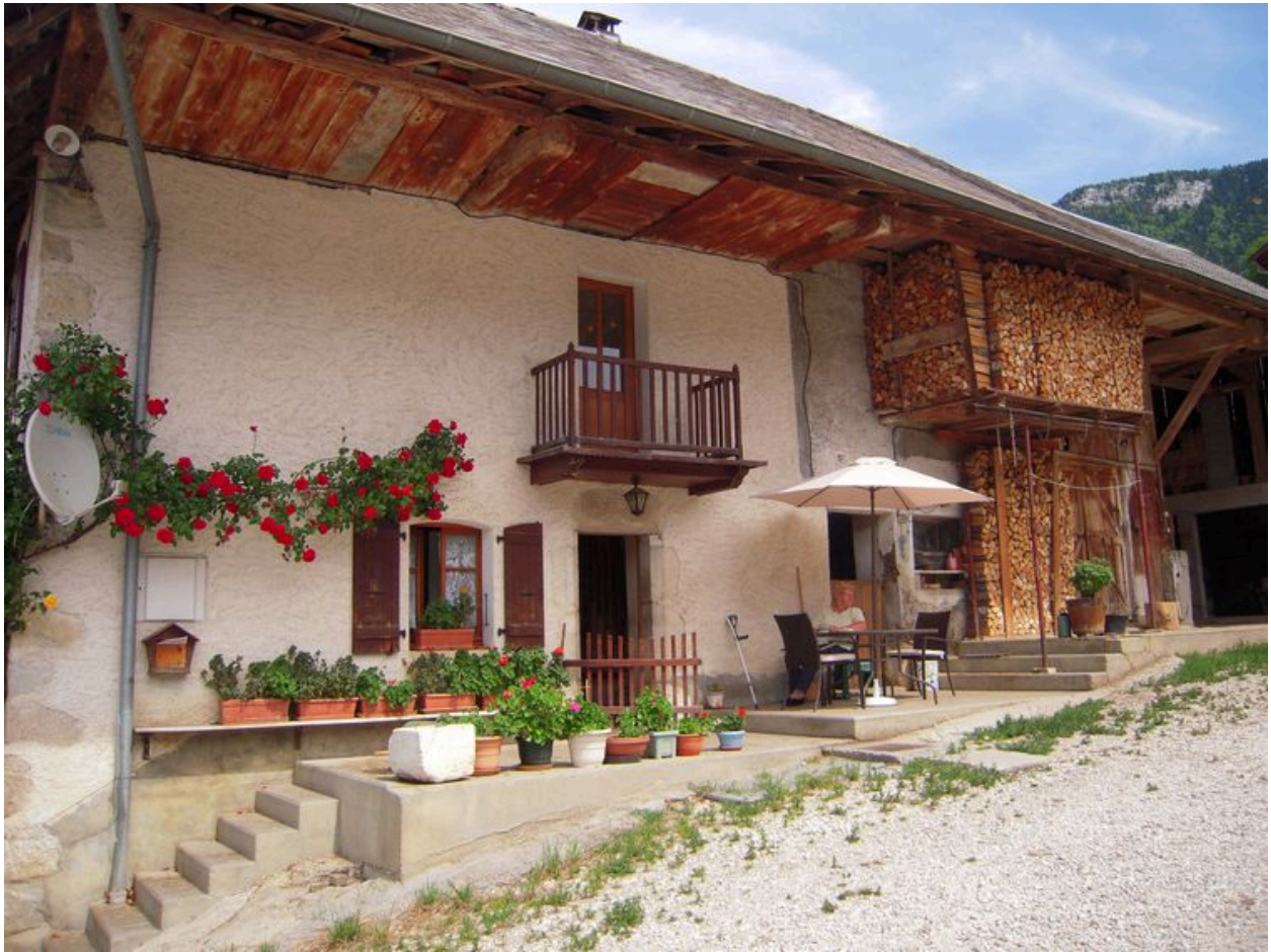
Vue de la façade sud.
