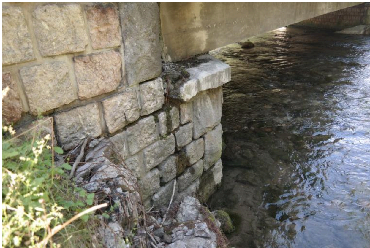
Pont des Portes, détail culée
