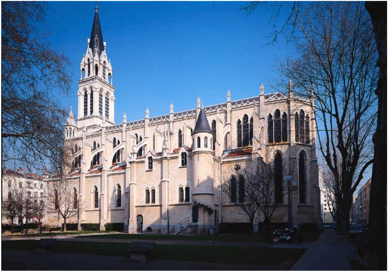
Vue générale de la façade sud
