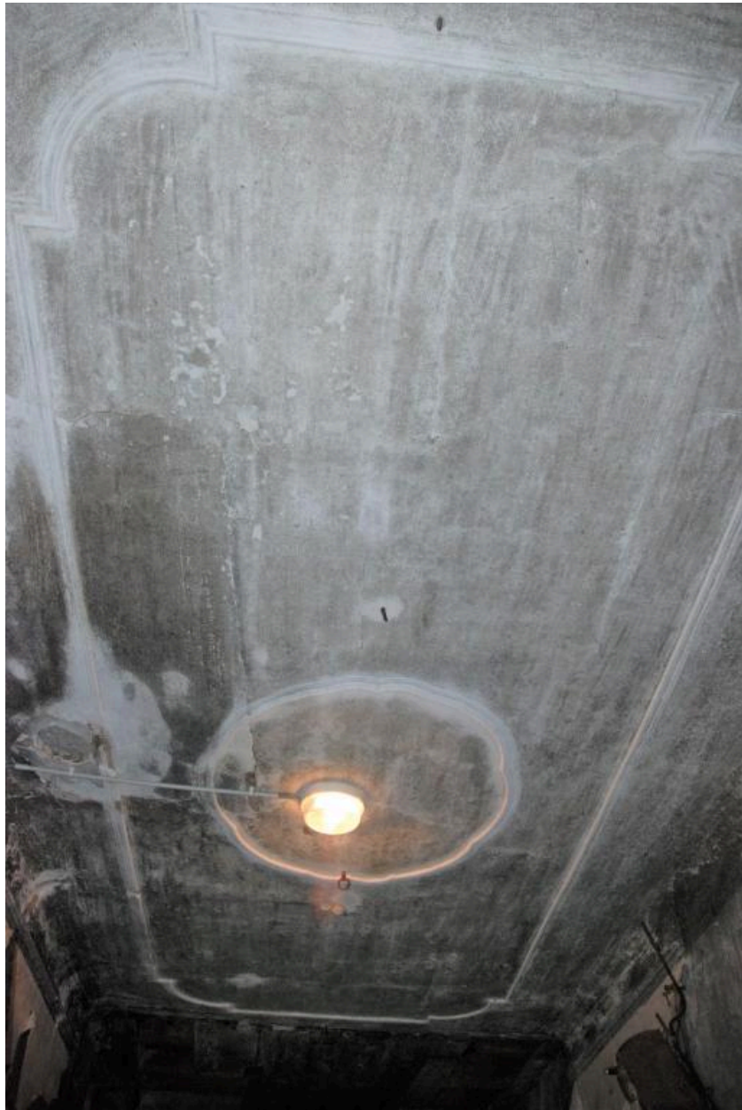
Corps principal, rez-de-chaussée, partie nord, ancienne cuisine (Cf. Plan RDC 3), vue d'ensemble de la mouleure du plafond.
