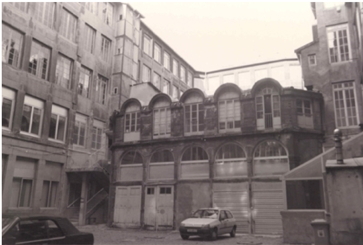
Façade sur cour
